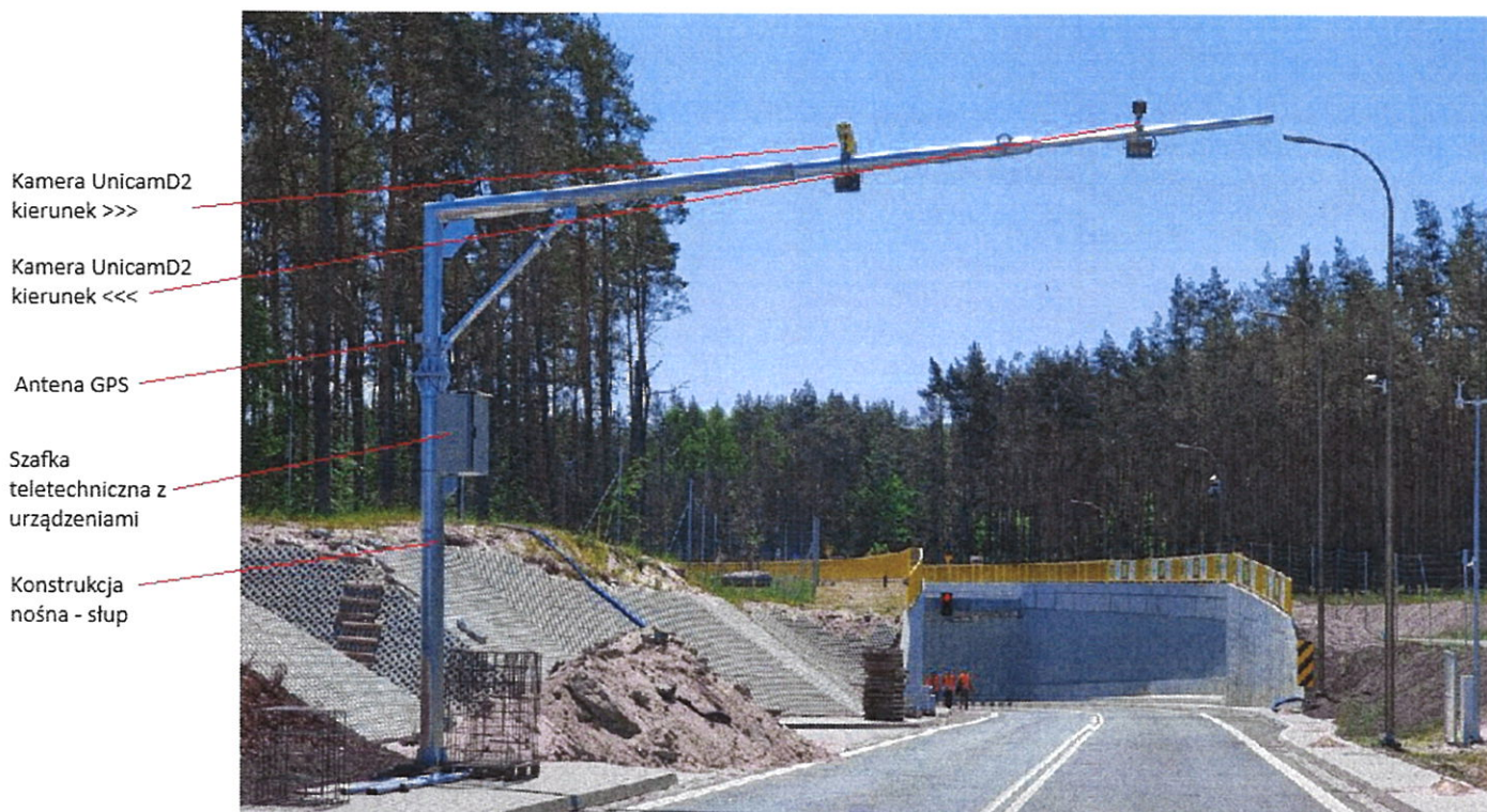
Rysunek 1 Instalacja prędkościomierza
